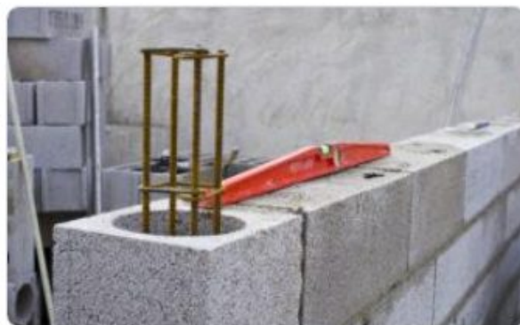
PHOTO Chaînage vertical en attente dans l'angle
