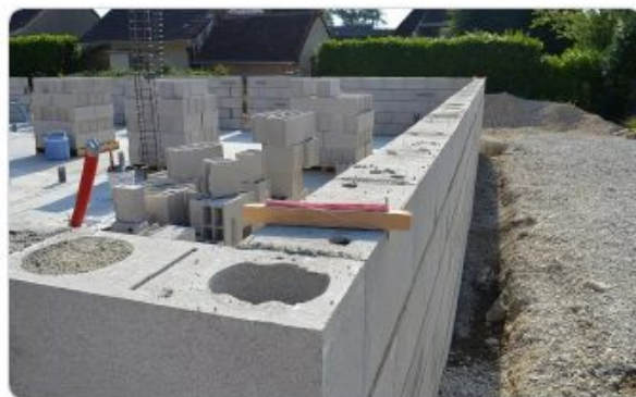
PHOTO Élévation en parpaing de 20
