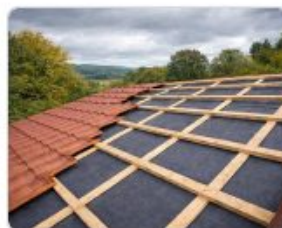
Écran sous toiture + tuiles
