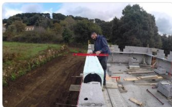
PHOTO Coffre de volet roulant encastré
