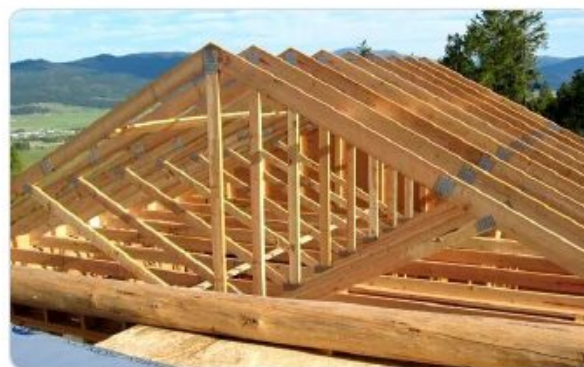
PHOTO Charpente fermettes industrielles
