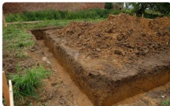
PHOTO Fouilles en rigole sur le terrain
