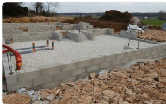
PHOTO Préparation : hérisson + réseaux
