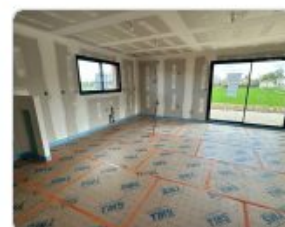
TMS — isolation plancher bas
