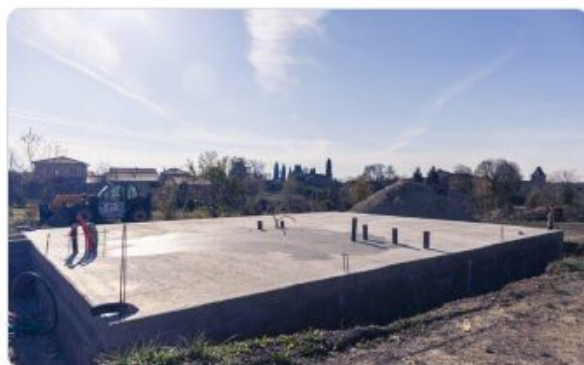
PHOTO Dalle coulée en béton
