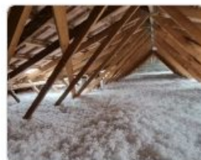
Laine de verre soufflée (combles)
