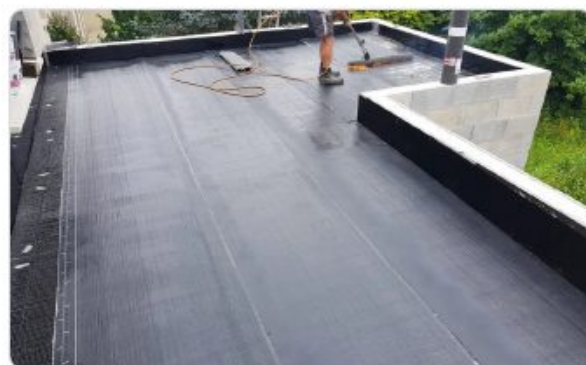
PHOTO Étanchéité de toit-terrasse
